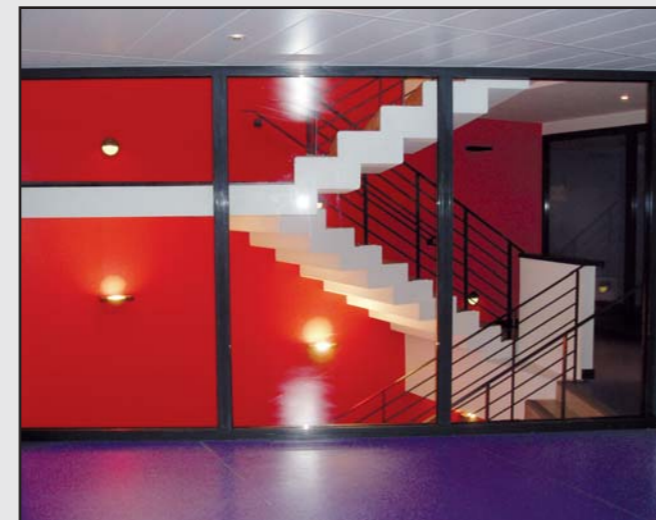
Cloison vitrée CF 1h en aluminium anodisé avec vitrophanie. Cloison vitrée CF 1h en acier thermolaqué. 1h Fire-Rated anodized aluminium partition with decorative films. 1h Fire-Rated partition with painted steel profiles.
